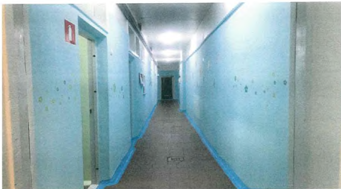
Фото № 7-8: Пути движения внутри задания
