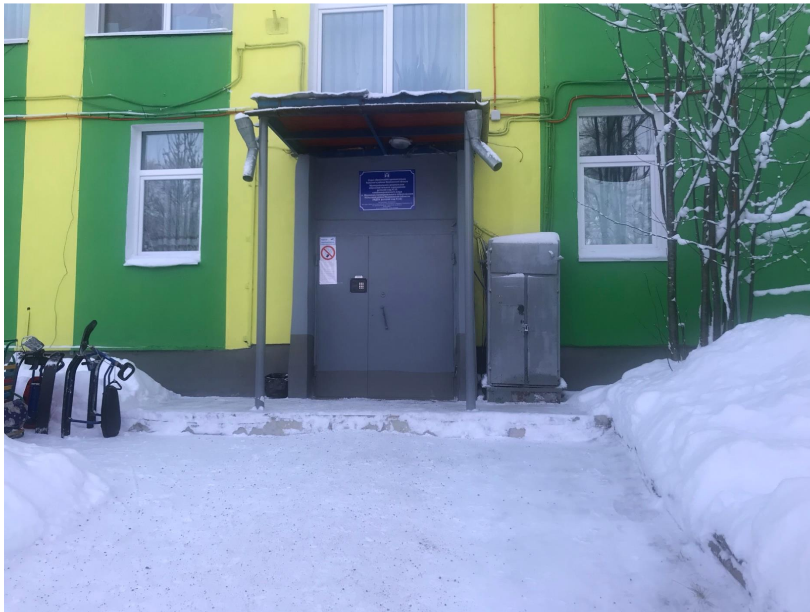
Центральный вход в учреждение
